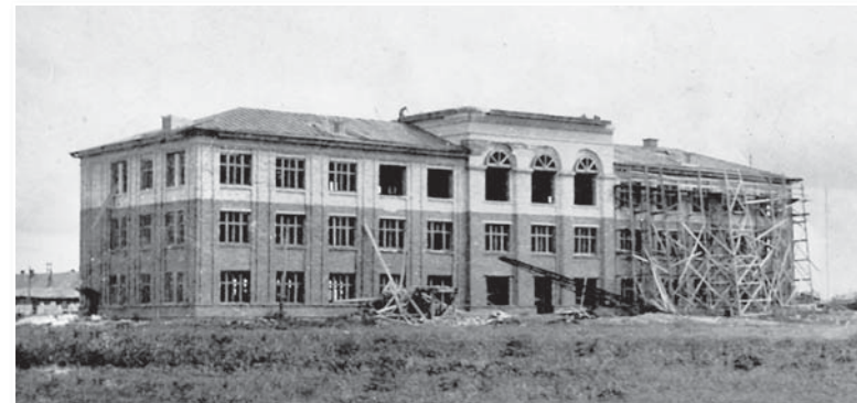
Строительство НИИОХа. Фото 1951 года
