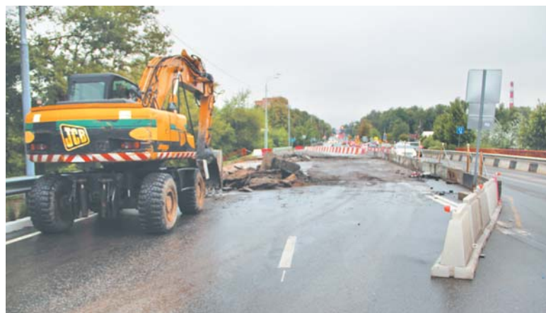
Ремонтные работы на мосту по ул. Мира
