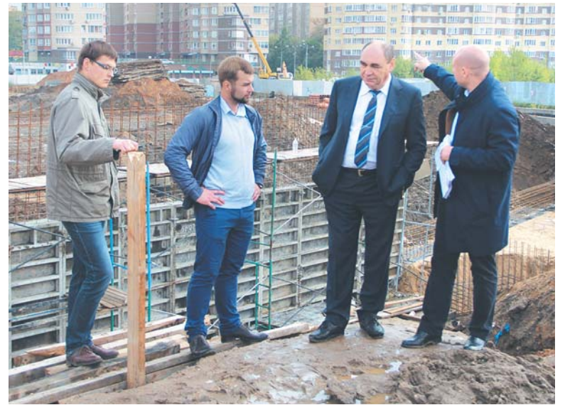
Александр Казаков проверил ход строительства футбольного поля по ул. Рождественской
