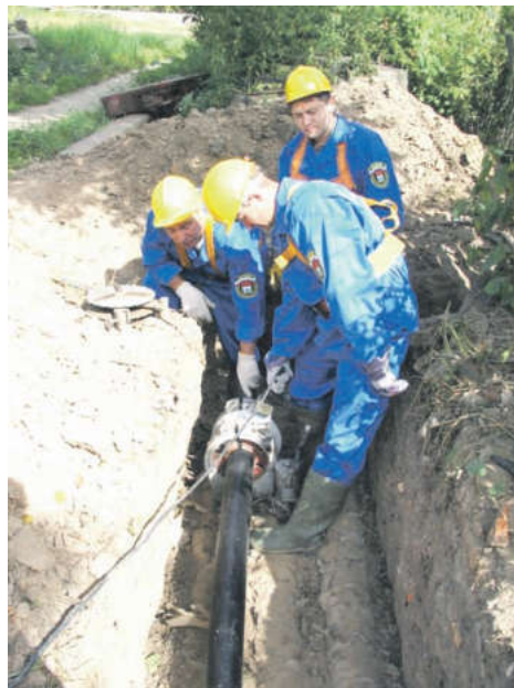
За последние пять лет переложено около 50 километров водопроводных сетей с заменой стальных трубопроводов на новые полиэтиленовые трубы.
