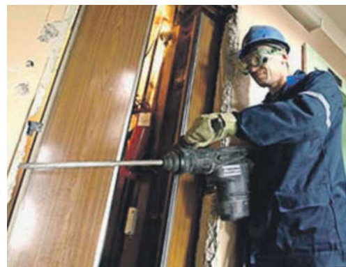
В этом году в 46 домах заменят 182 лифта
