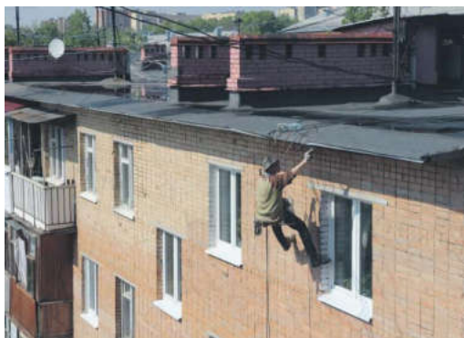
Ремонт кровли не останется без внимания
