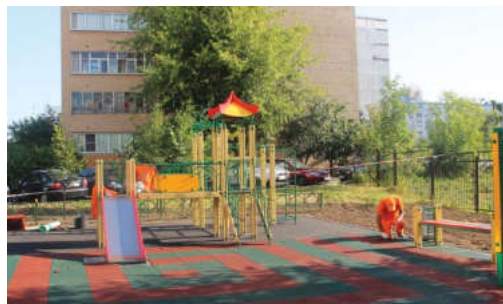
На площадке возле улицы Шараповской, д. 6, корп. 1 ведется замена покрытия
