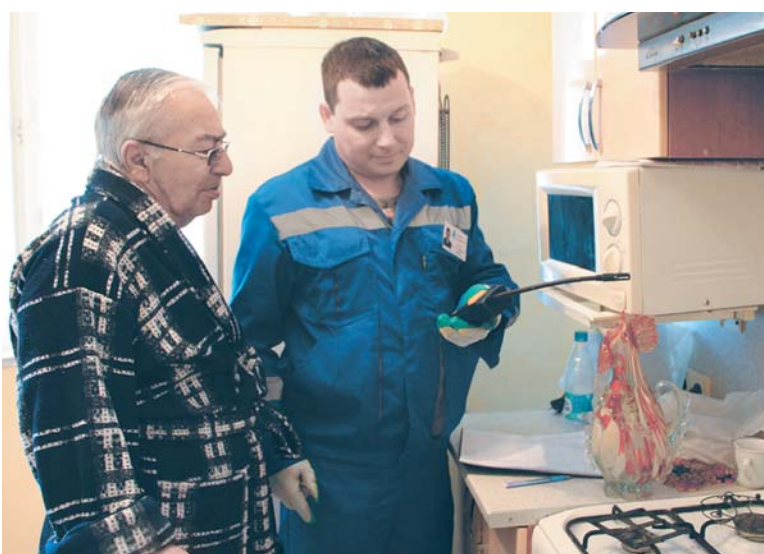
Сотрудники ООО «СервисГаз» проводят осмотр газового оборудования у собственников жилья, заключивших с организацией договоры на его обслуживание
