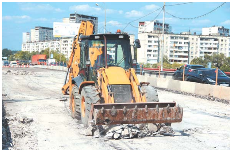
Работы на эстакаде по Олимпийскому проспекту идут полным ходом
