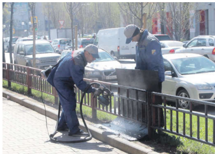
Коммунальные организации приступили к покраске ограждений
