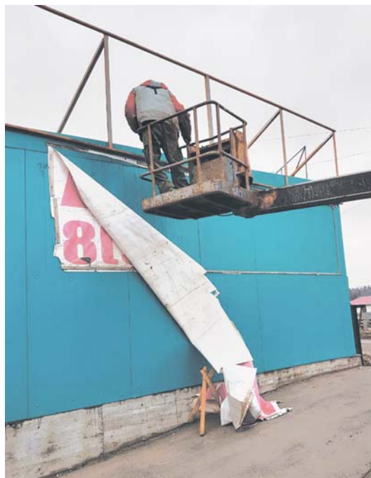
На минувшей неделе незаконные рекламные вывески были демонтированы на Волковском шоссе
