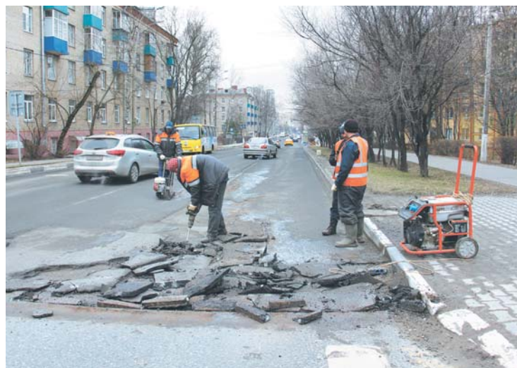
На этой неделе дорожники проводят ямочный ремонт на ул. Летной
