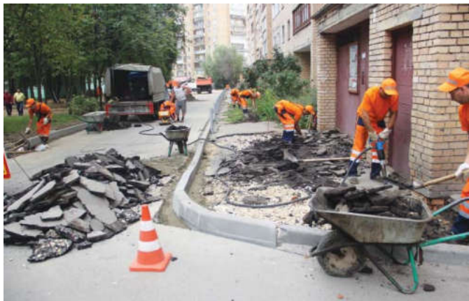
Ремонт дорожного покрытия идет на ул. Юбилейной, д. 3, корп. 1
