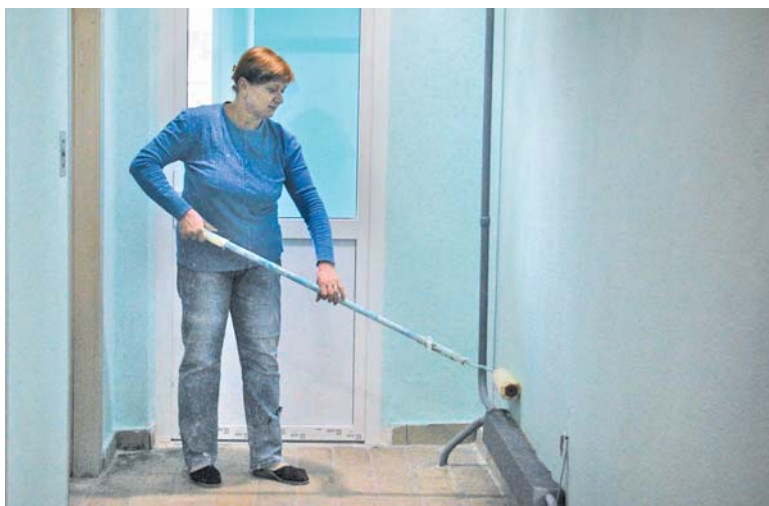
В доме № 7 на ул. Индустриальной продолжается ремонт подъезда
