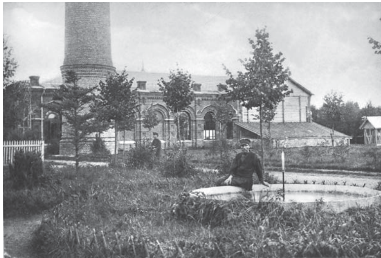
Мытищинская водокачка, начало XX века
