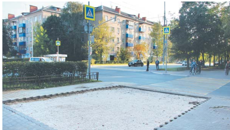
Понижение бордюра в рамках организации доступной среды на перекрестке Новомытищинского пр-кта и ул. Щербакова
