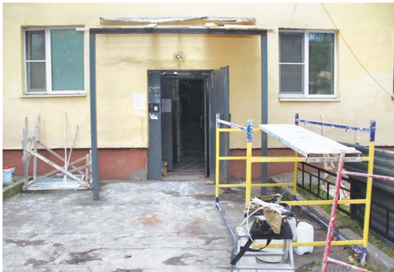
Ремонт подъезда на ул. Широкой, д. 20 в д. Беляниново
