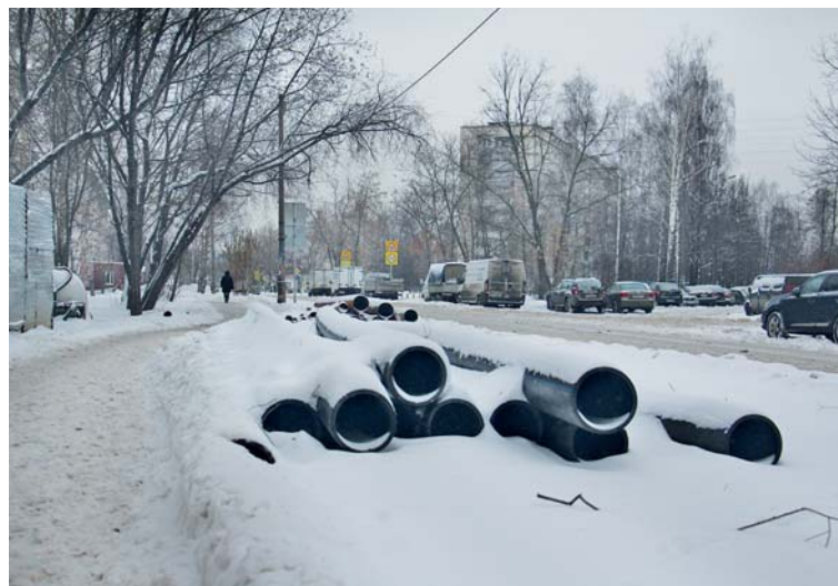
Продолжается перекладка сетей водоснабжения в 24-м микрорайоне города (ул. Индустриальная)
