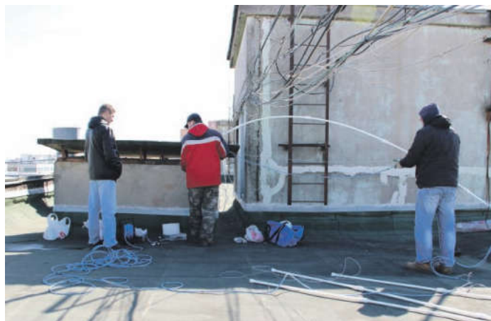
При помощи специального оборудования элемент, ограничивающий водоотведение, спускают в общедомовой канализационный стояк
