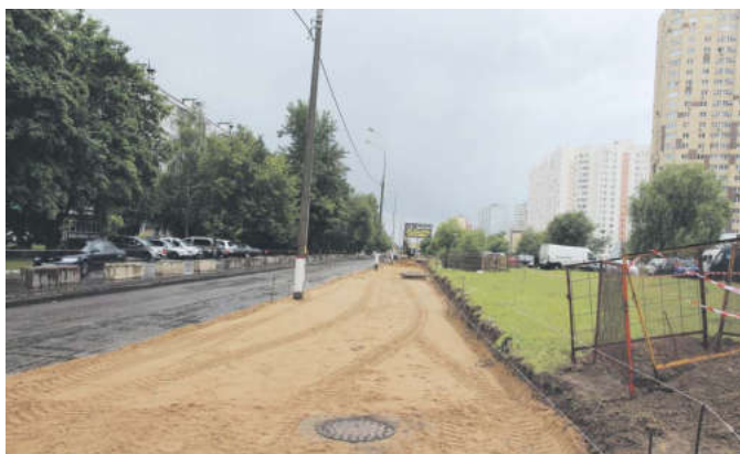
При реконструкции улицы Юбилейной будет значительно расширена проезжая часть
