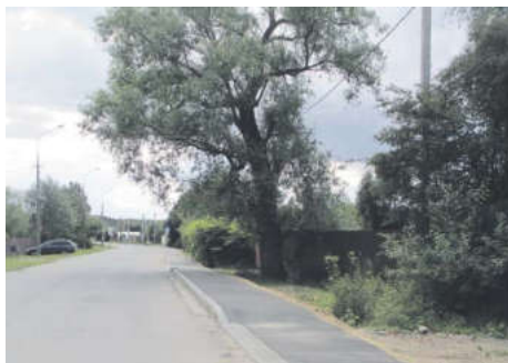
Деревня Беляниново, тротуар по ул. Центральной
