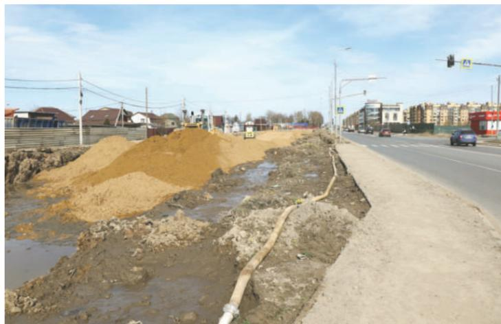
«Мосавтодор» отремонтировано асфальтовое покрытие, продолжаются дренажные работы. Уже готов односкатный профиль, что позволяет скапливаемой воде при любых погодных условиях уходить в сторону кювета.
